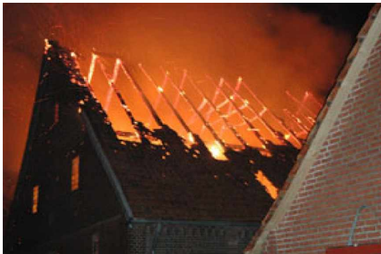
Beim Eintreffen der Einsatzkräfte steht bereits die Scheune im Vollbrand
