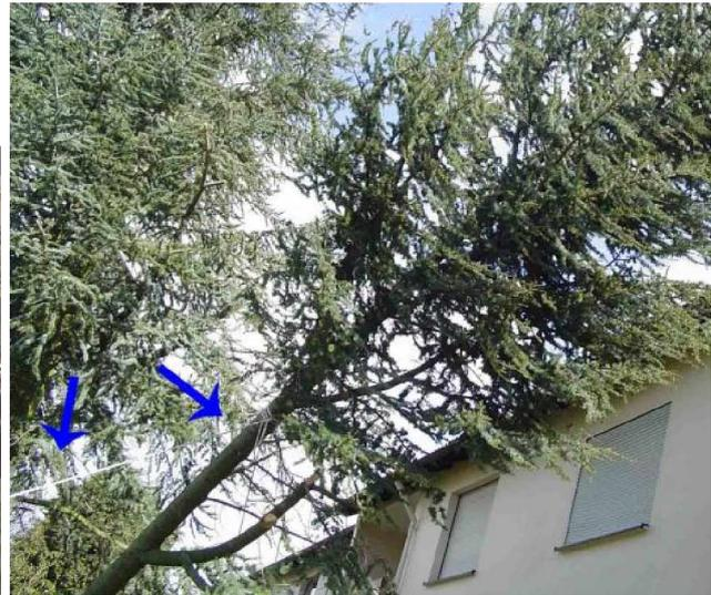
**Linkes Bild:** Mit dem Unterbau wurde verhindert, dass der Baum von seiner Abbruchstelle abrutscht. Der blaue Pfeil zeigt den Mehrzweckzug, mit dem er dann abgelassen wurde. **Rechtes Bild:** Die blauen Pfeile zeigen den Mehrzweckzug, mit dem der Baum vom Haus angehoben wurde
