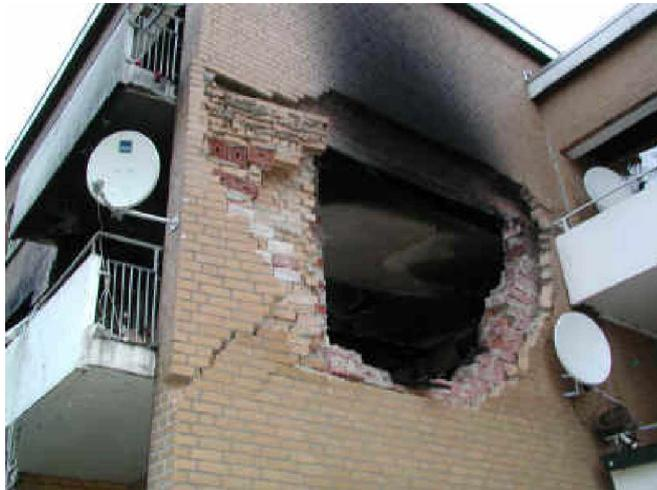
Unterstützung der Feuerwehr Rinteln mit dem Rüstzug. Aufgrund des Schadensumfanges an dem Haus, sind die Abstützmaterialien der Feuerwehr nicht ausreichend, so daß Einheiten des THW diese Aufgabe übernehmen.
